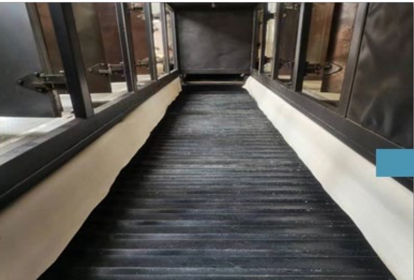
干燥箱底板（更换前）
