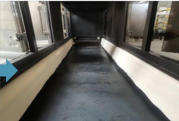
干燥箱底板（更换后）
