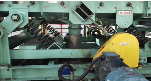
机泵和振动器安装防震垫
