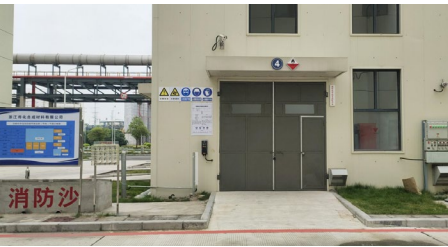
危险废物贮存仓库
